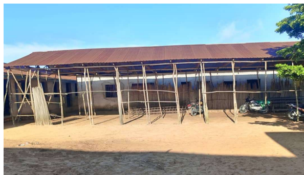
Uitbreiding van het bibliotheekgebouw in uitvoering
